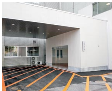
救急出入り口も工事完了
